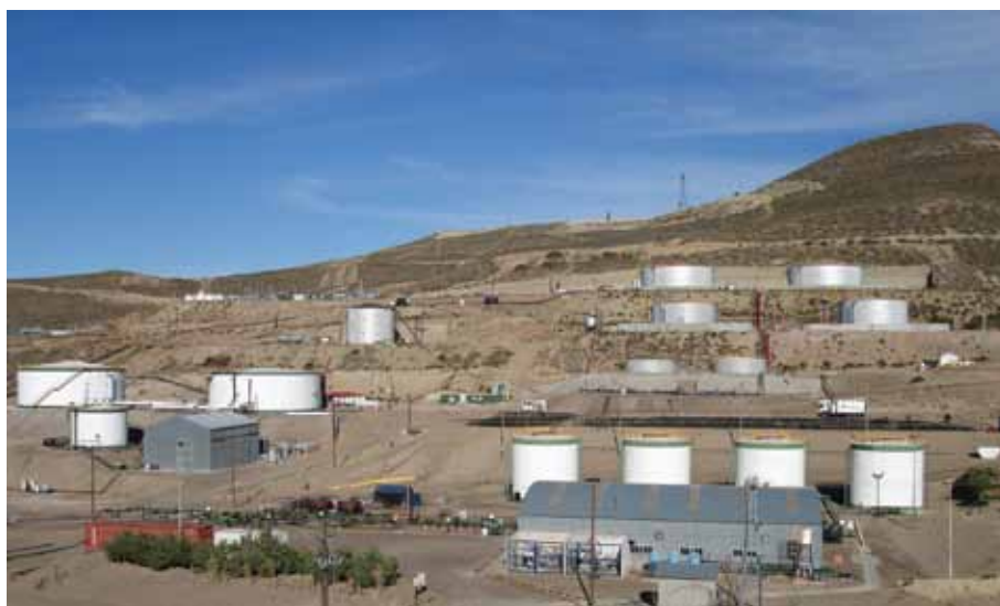
Figura 15. Planta de tratamiento de crudo.
